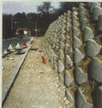
végétale, et équiper des talus courbes, à angles droits ou à forte variation de pente (de 45° à 90°). Des murs de grande hauteur peuvent aussi être réalisés, pour peu que le massif soit renforcé de nappes géotextiles. Dans ce cas, le calcul est effectué par la société au moyen du programme Carthage (LCPC-IRGM). De 25 à 60 m<sup>2</sup> de mur par jour et par équipe de pose peuvent être mis en œuvre (Altus).
