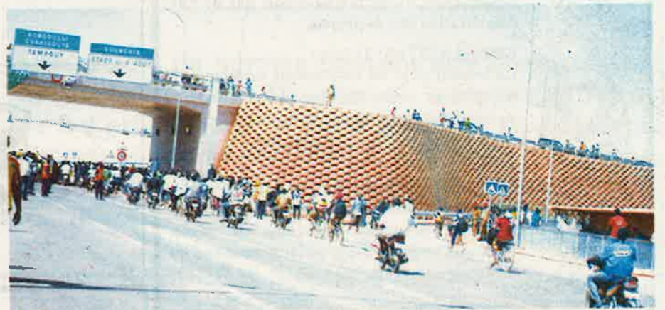
Après l'inauguration, les usagers ont pris d'assaut les voies pour découvrir l'ouvrage
