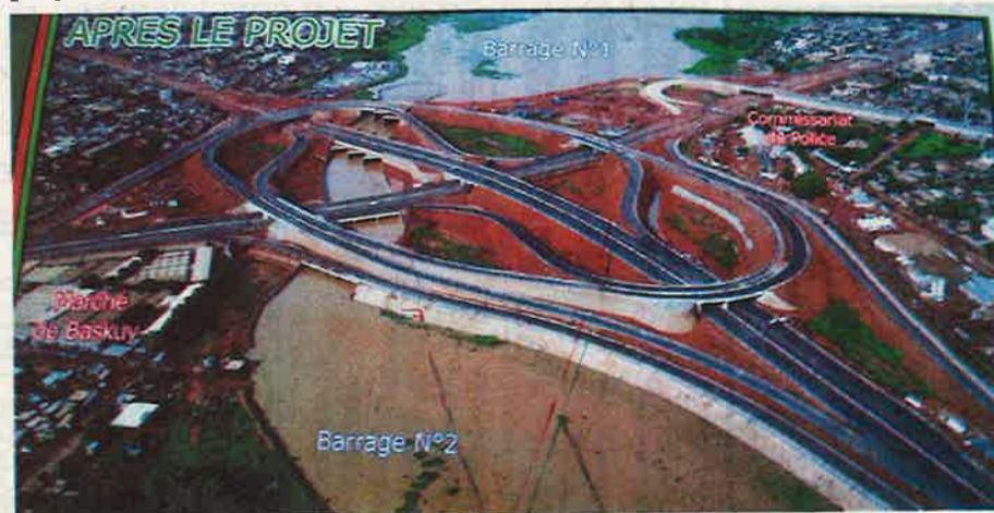
Une vue de l'ouvrage
