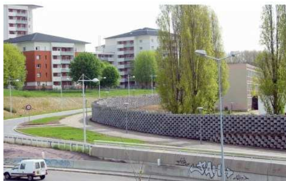
Photo d'un mur construit avec Atalus double
