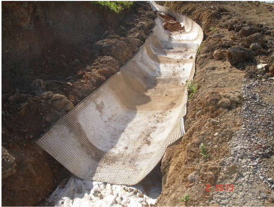
Figure 20. Mise en œuvre du géocomposite étanche
