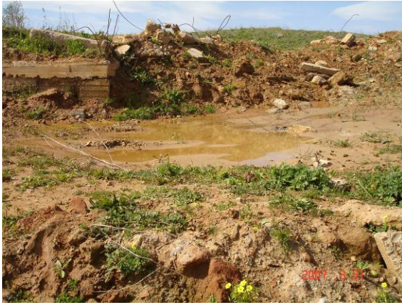
Figures 3 et 4. Stagnation des eaux en amont dans des fondations abandonnées
