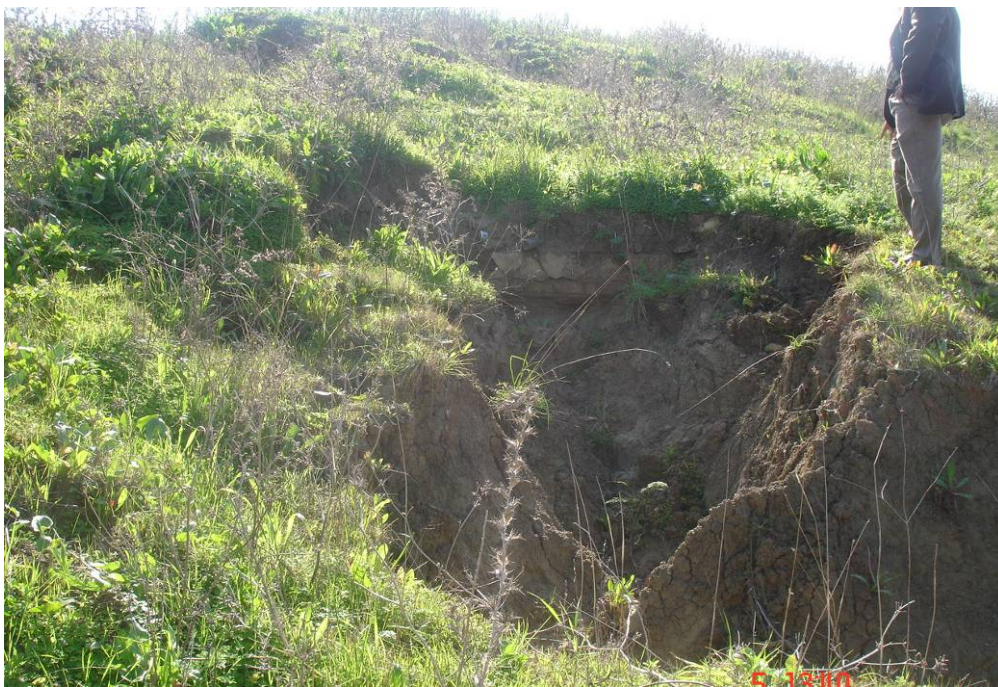
Figure 14. Erosion causée par les eaux de ruissellement en amont du talus
