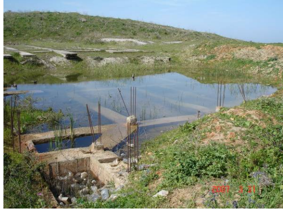
Figures 3 et 4. Stagnation des eaux en amont dans des fondations abandonnées
