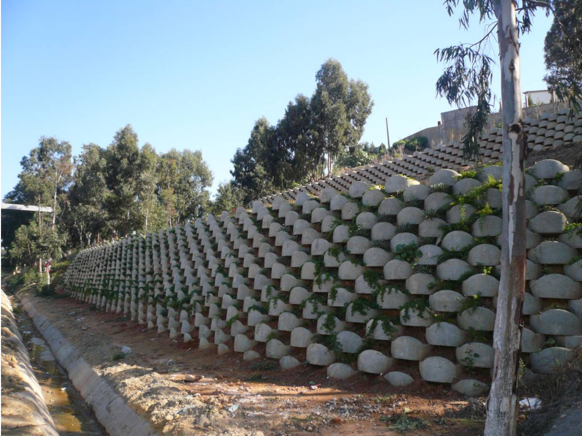
Figure 25. Ouvrage achevé avec la végétalisation
