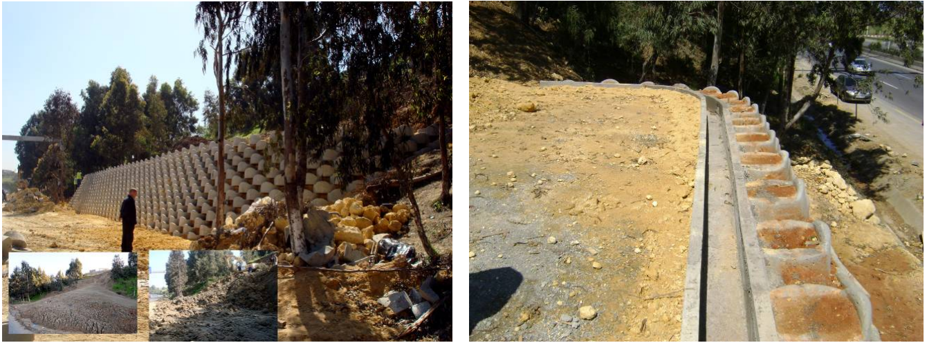
Figures 22 et 23. Ouvrage en phase de construction
